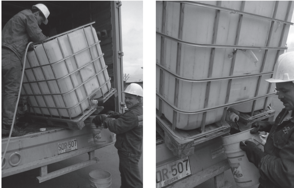
Imagen 1. Lavado de isotanques para transporte de producto
