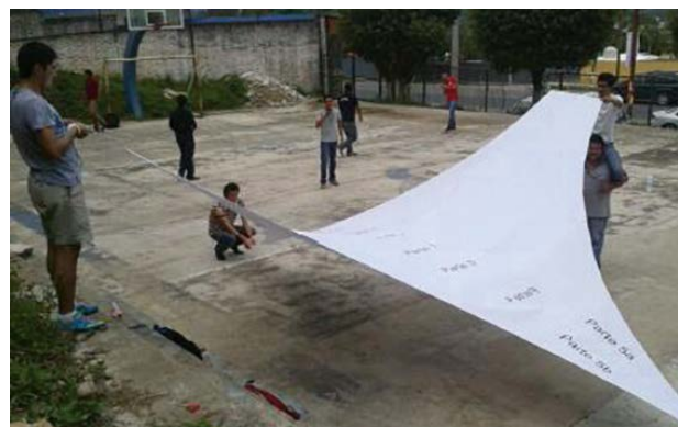
Figuras 39, 40, 41. Representación de la membrana dividida en secciones en las que se une la tela malasombra por medio de una costura industrial Fuente: Morales (2014b).
