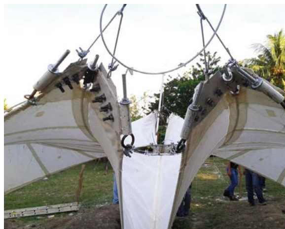
Figuras 32, 33, 34. Conexiones metálicas de la tenso-estructura Fuente: Morales (2013b).
