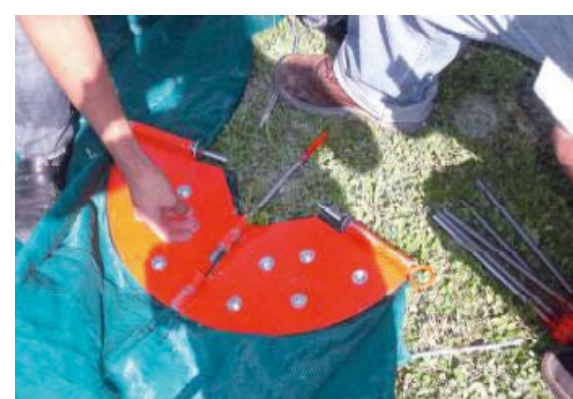
Figuras 39, 40, 41. Representación de la membrana dividida en secciones en las que se une la tela malasombra por medio de una costura industrial Fuente: Morales (2014b).
