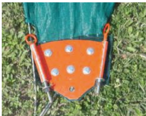
Figuras 42, 43, 44. Montaje de las uniones metálicas en la membrana Fuente: Morales (2014b).
