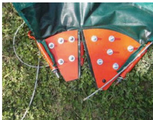
Figuras 42, 43, 44. Montaje de las uniones metálicas en la membrana Fuente: Morales (2014b).
