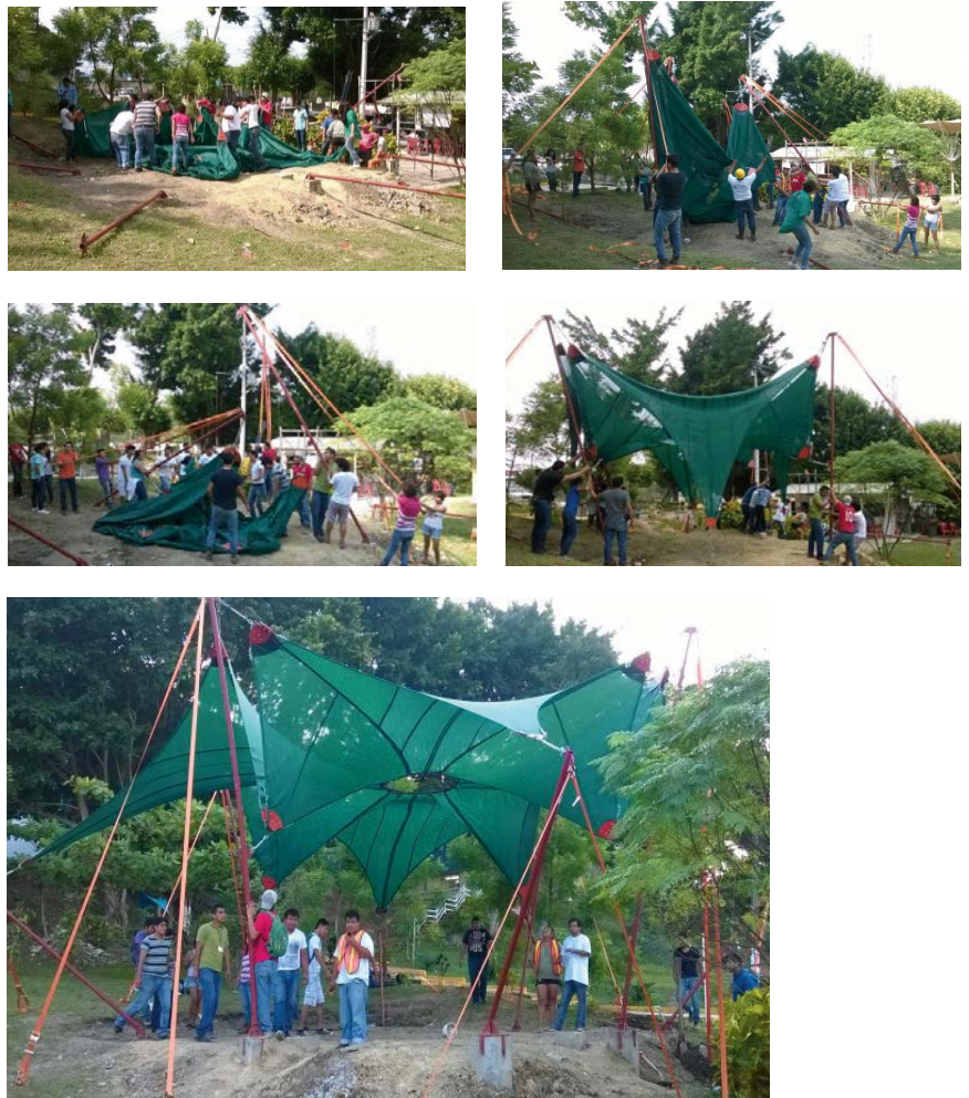
Figuras 48-52. Primer montaje de la velaría Fuente: Morales (2014b).
