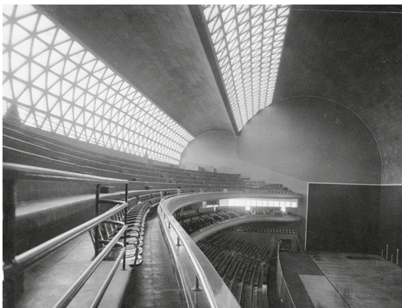
Figure 4. Frontón Recoletos (1935), Madrid, por Eduardo Torroja Source: Cassinello, Schlaich y Torroja (2010).
