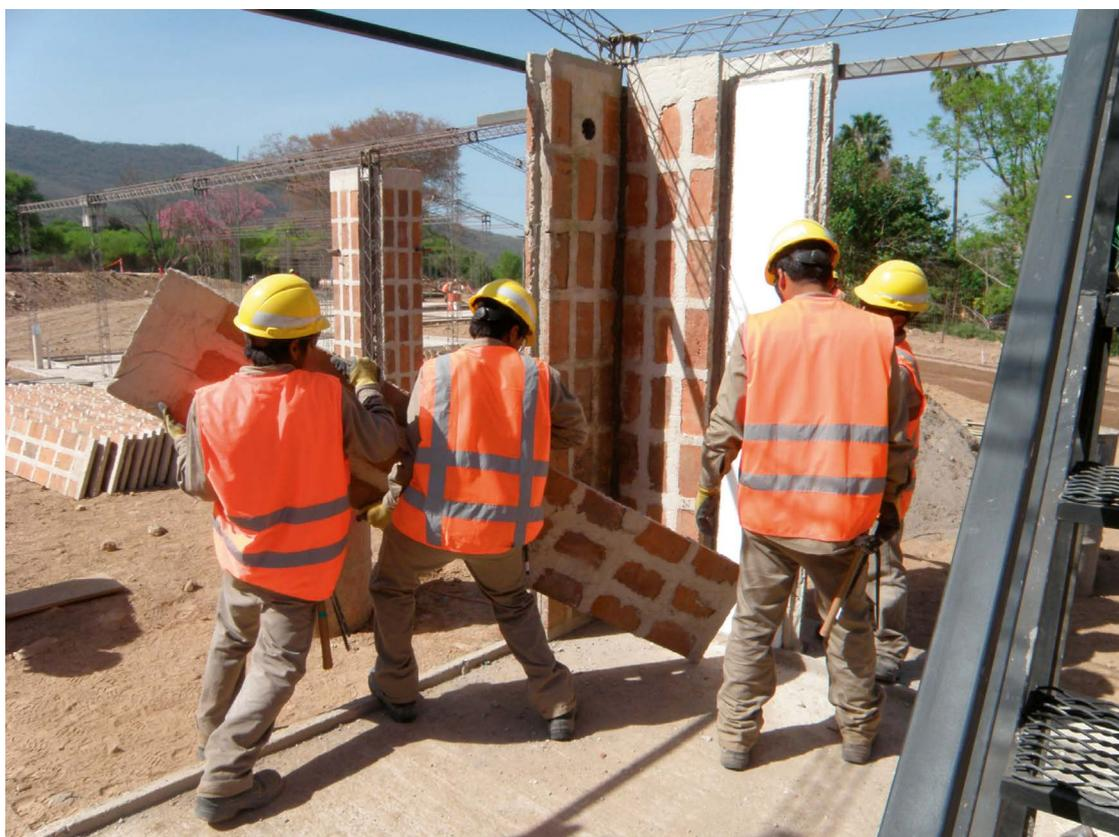
Figura 4. Montaje de las placas BENO sobre estructura UMA en Puesto Viejo
