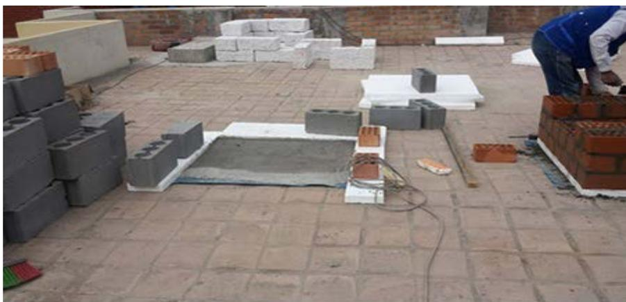
Figura 3. Aislamiento en cubierta de los módulos.
