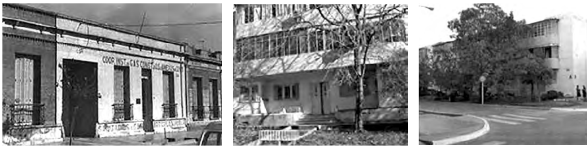
Adobe. Viviendas tradicionales
