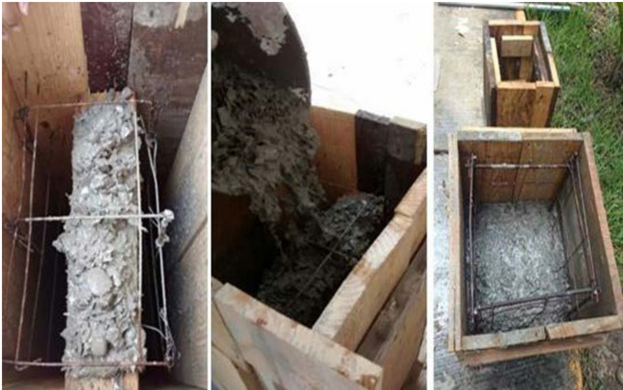
Figura 17. Vaciado de mezcla en el macetero
