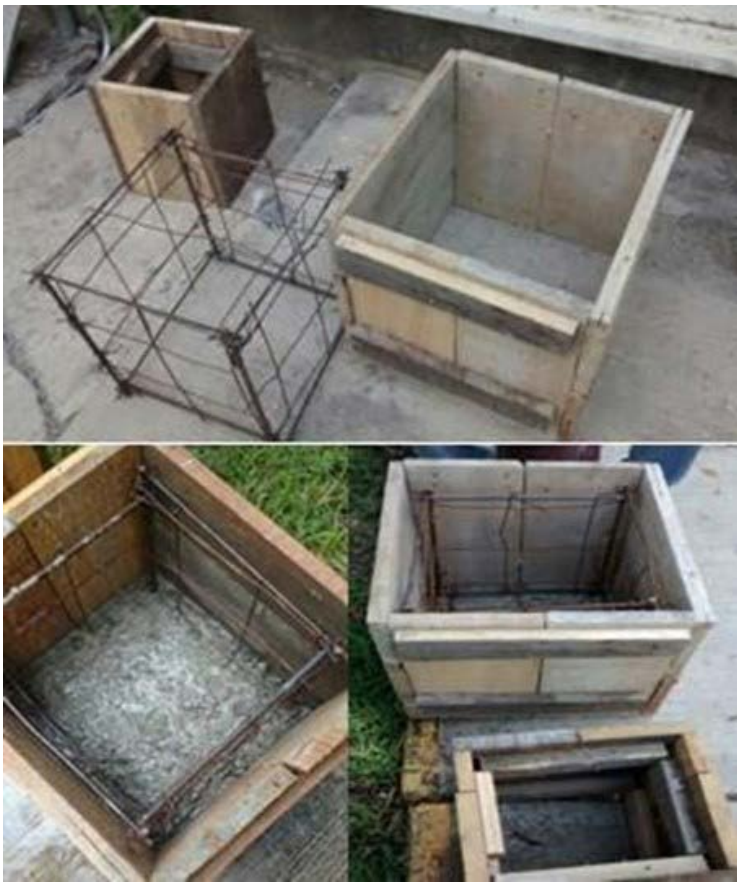
Figura 16. Cimbra y armado del macetero
