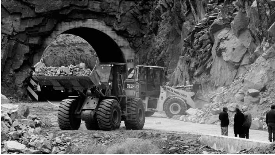
Figura 10. Máquinas viales despejando la caída de bloques del Túnel n.º 3 de la Ruta Internacional n.º 7, originada el 14 de noviembre del 2011 por lluvias intensas durante 2 días. Fuente: Titiro 2011.
