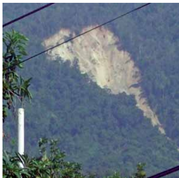
Figura 2. Vista del deslizamiento ocurrido en el 2010, en el frente de montaña septentrional de la cuenca de drenaje del río San Julián (parroquia Caraballeda, estado Vargas), en el sector conocido como La Chara.
