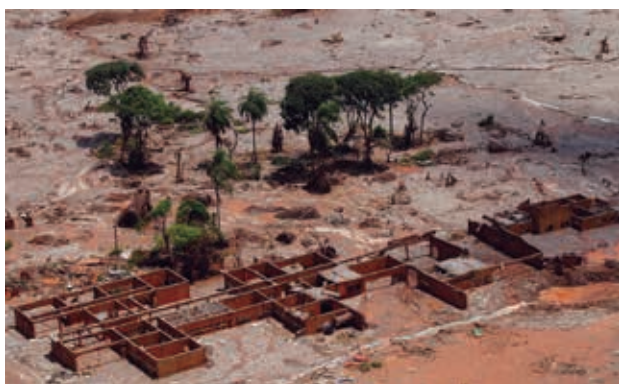
Figura 4. Escola em Bento Gonçalves destruída pela lama. Fonte: Barbara 2015.
