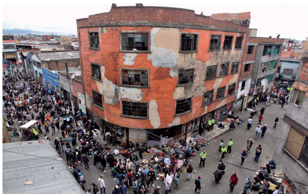
Figura 2. Edificio desgastado en el Bronx.
