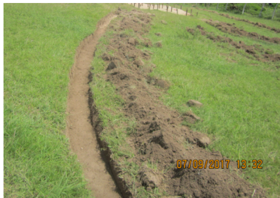
FIGURA 7. Acequias de contorno construídas
