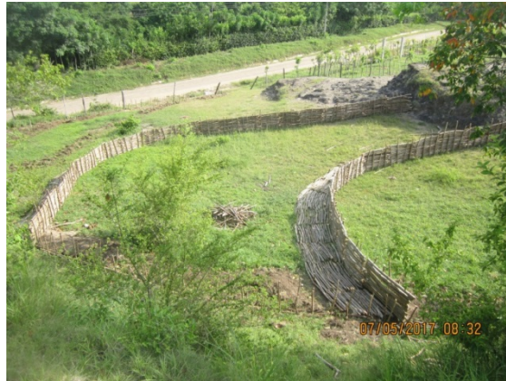
FIGURA 12. Presas de varas construídas.
