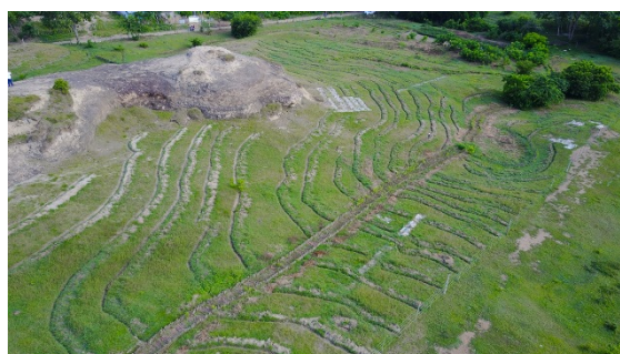
FIGURA 9. Acequias de contorno conectadas con toboganes vegetativos.
