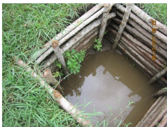
FIGURA 2. Inicio del retoño de material vegetal en cajas de disipación y retención de agua lluvia.
