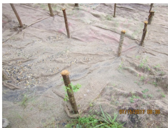
FIGURA 18. Rebrote de material vegetal en biomantos artesanales.
