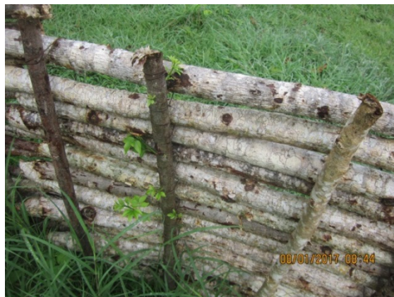
FIGURA 13. Rebrote de material vegetal vertical en presas de varas construídas.
