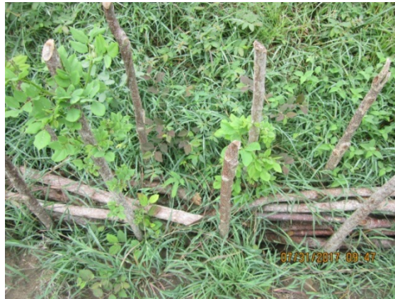
FIGURA 11. Retoño de material vegetal en trinchos de contención.
