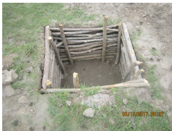
FIGURA 1. Cajas de disipación construidas.
