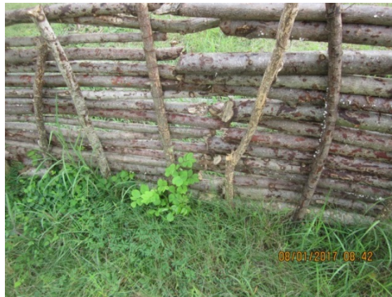
FIGURA 14. Rebrote de material vegetal horizontal en presas de varas construidas.
