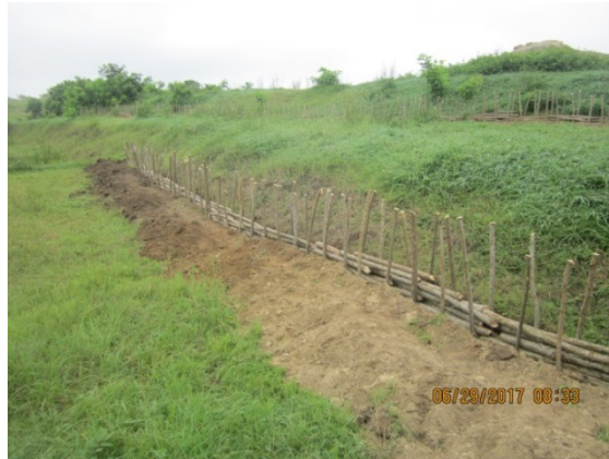
FIGURA 10. Trinchos de contención construídos.
