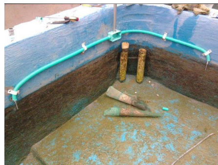
FIG. 15. Instalación termocuplas tipo J
