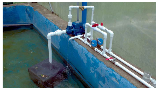
FIG. 17. Instalación de la motobomba y las electroválvulas
