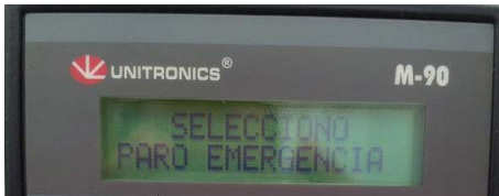
FIG. 13. Display “Paro de emergencia”
