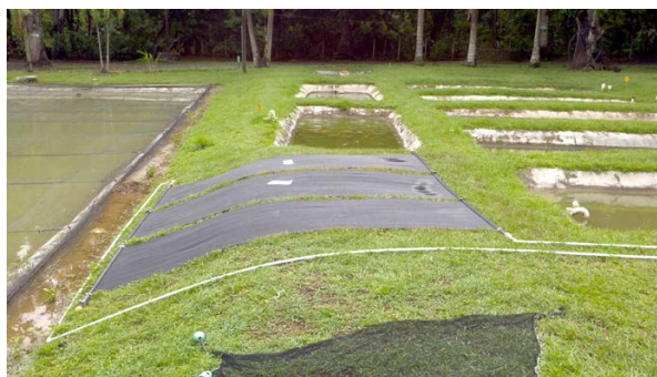
FIG. 18. Instalación de los colectores solares
