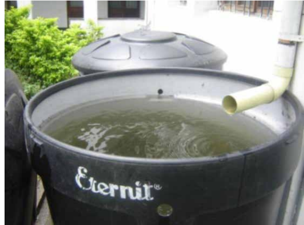
FIG. 3. Almacenamiento de aguas lluvia. Fuente: Medina, C.
