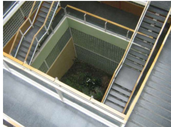
Figura 4 Fotografía del Claustro
