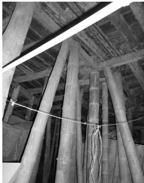
Figura 1. Refuerzo artesanal de la estructura.
