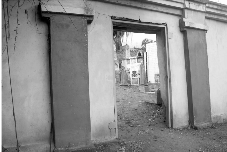
Foto n° 16: La entrada trasera del cementerio de Ráquira
