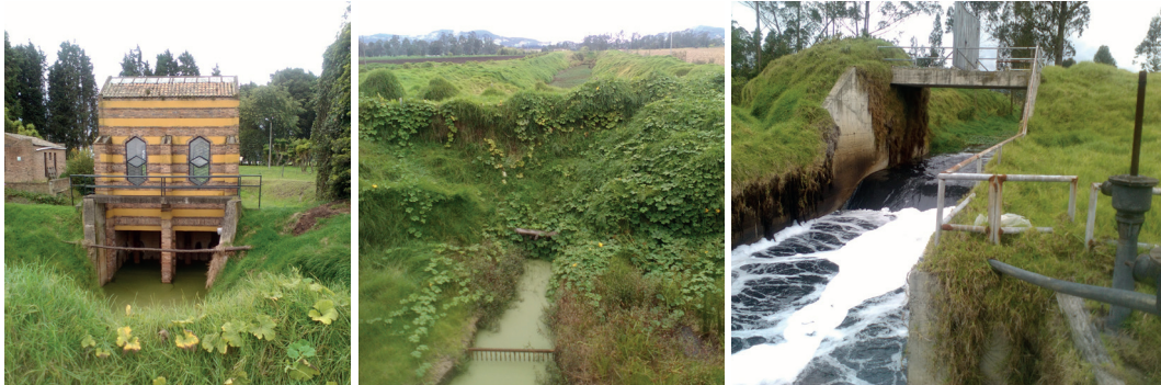
Imagen 2. Estación de El Pino y canal Acacias, que nace de la misma estación hasta dar con el azud, punto de encuentro con el río Bojacá
