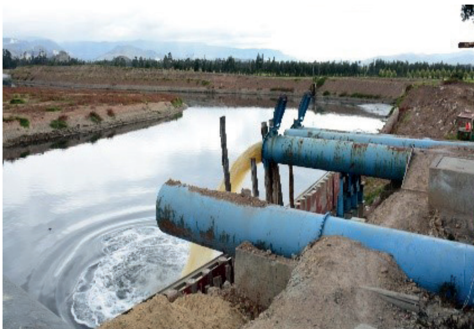
Imagen 3. Tubos de desagüe de la estación El Tabaco
