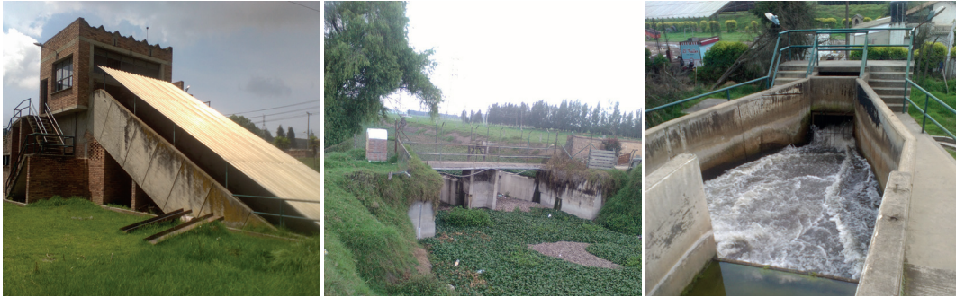
Imagen 1. Estación de Mondoñedo y compuerta anexa sobre el río Balsillas, con la que se regula el nivel de aguas de la laguna de La Herrera
