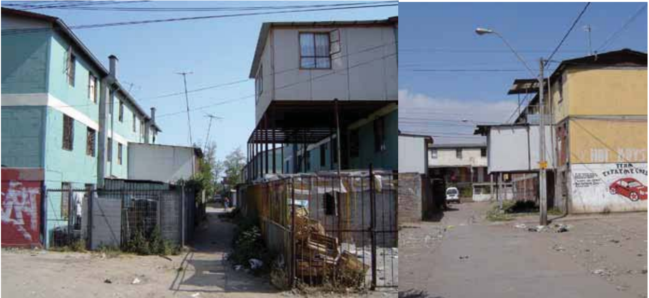
Figura 5. Ampliaciones individuales en conjuntos de viviendas sociales. Fuente: Rodríguez & Sugranyes [8]
