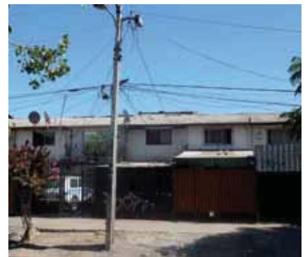
Figura 2. Vivienda multifamiliar dos pisos. Fuente: Rodríguez & Sugranyes [8]
