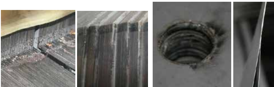
Figura 22. Hallazgos: Traslapes y perforaciones en corto, láminas soldadas en sus extremos Fuente: elaboración propia
