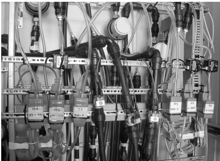
Figura 10. Elementos del cuadro de control hidráulico del piloto. bombas, sensores de nivel, electroválvulas.
