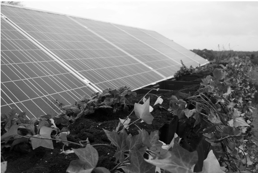
Figura 3. El sustrato de la cubierta vegetal se encuentra contenido dentro de un sistema modular de plástico reciclado, lo cual le permite también el ser desmontado a la hora de transportarse el prototipo.
