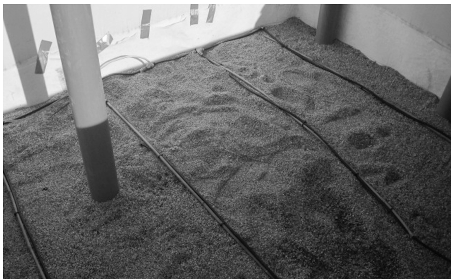
Figura 16. Sobre el material granular se coloca el sistema de distribución que alimenta al humedal con el agua contaminada.
