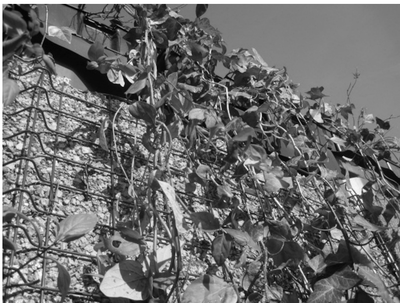
Figura 4. La pared vegetal, en combinación con el corcho, permite tener temperaturas en verano, dentro del contenedor, cercanas a los 29°C.
