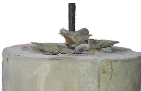
Figura 6. Falla por arrancamiento en anclaje estructural posinstalado
