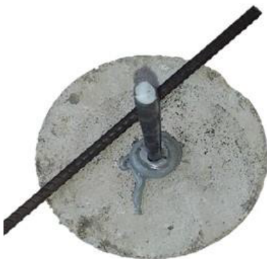
Figura 5. Falla del acero en anclaje estructural posinstalado
