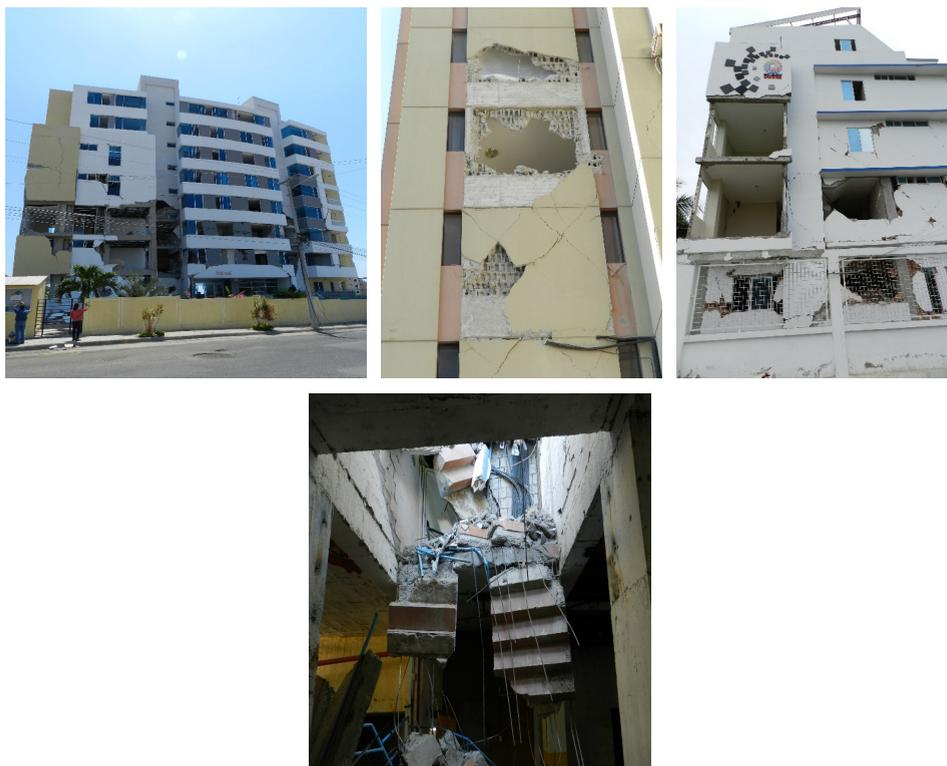
Figura 1. Caída de fachadas y escaleras en el sismo de Ecuador de 2016
