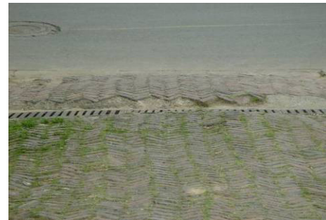
Figura 19. Vegetación en la calzada
