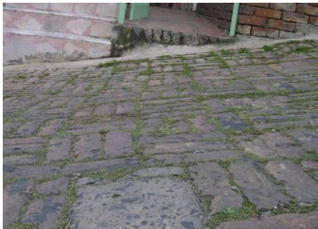
Figura 14. Fracturamiento CI
