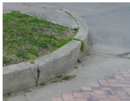
Figura 11. Fracturamiento CE
