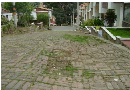
Figura 15. Vegetación en la calzada
