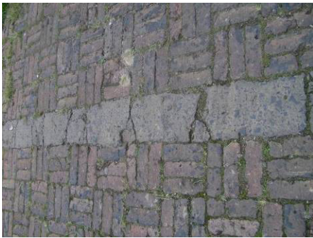
Figura 13. Desplazamiento de juntas
