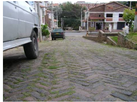
Figura 17. Desplazamiento de juntas
