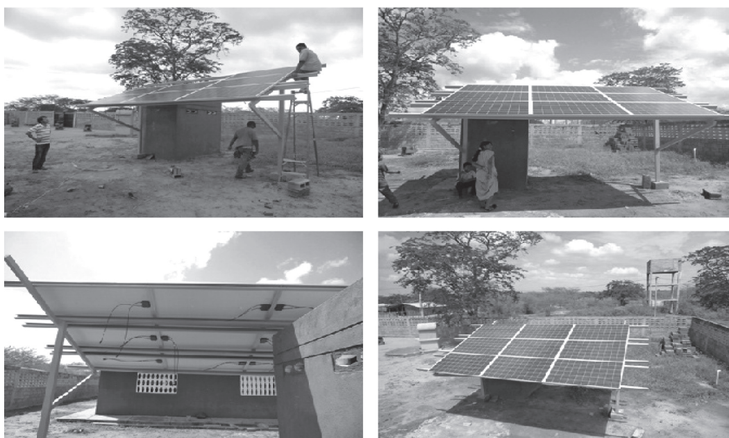
Figura 3. Instalación del sistema fotovoltaico en la comunidad Indígena Etokojo >ole.
