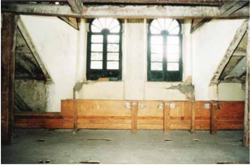
Foto 2. Silos de almacenamiento de trigo
