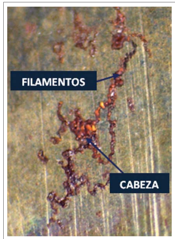
Figura 3. Corrosión localizada filiforme
