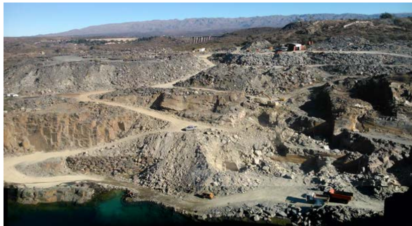
Figura 2. Foto panorámica de la cantera La Represa donde se observan accesos a diferentes frentes de explotación
