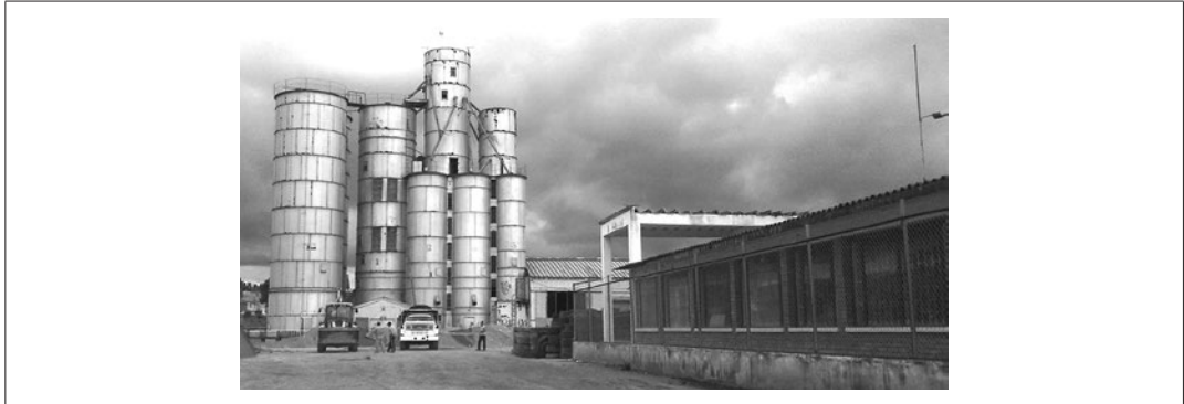
Figura 5. Silos del INA en proceso de desmonte
