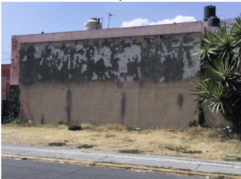
Figura 4. Estructura de fachada de vivienda en la colonia Los Héroes Ecatepec Tercera Sección
