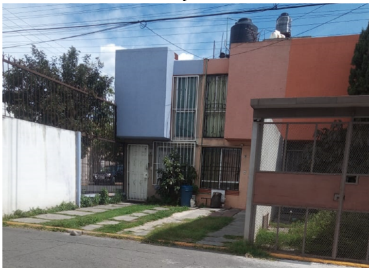
Figura 3. Fachada de las viviendas de la Unidad Habitacional Los Héroes Ecatepec Tercera Sección
